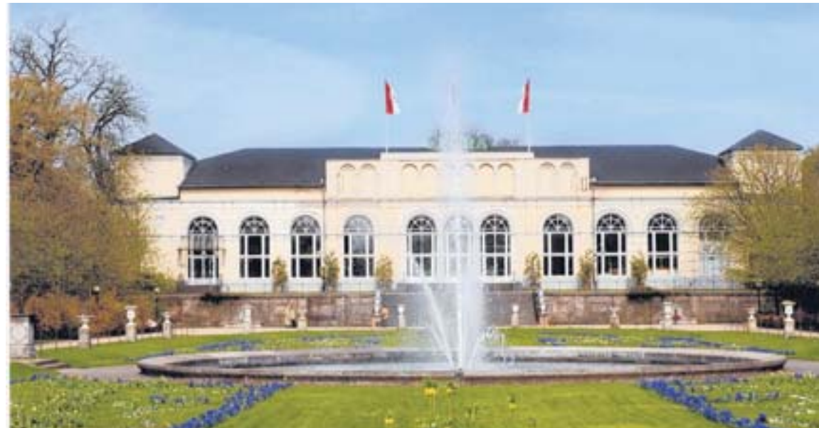
Gäste stehen derzeit in der Flora vor verschlossenen Türen . Die gesamte Anlage muss saniert und umgebaut werden. Vor Anfang 2011 werden die Arbeiten aber nicht beginnen. FOTO: KÖLNKONGRESS
